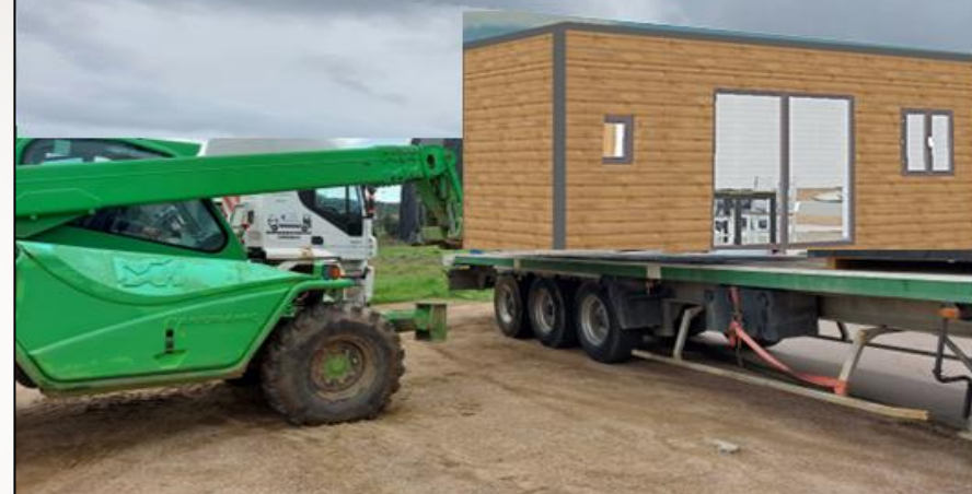
Mise en place avec camion grue
