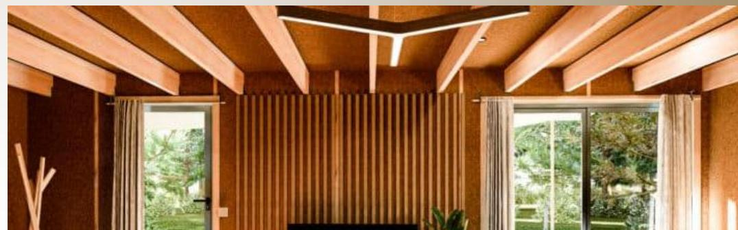
*Le plafond est livré comme suivant la photo. Nous pouvons ajouter de l'isolation entre poutres. Epaisseur 75 mm avec lambris en sous face,*
